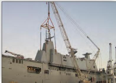
Íçamento sincronizado e posicionamento de carga
