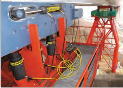
◀ Cilindros customizados usados em sistemas de levantamento progressivo da ponte
