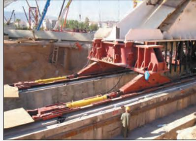
◀ Cilindros customizados para operações de levantamento e de deslocamento lateral.
