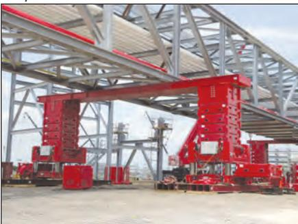
▼ Bloco de Alimentação "SyncHoist" para acionar 4 pontos de levantamento
