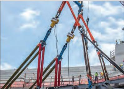
◀ Cilindros customizados SyncHoist para colocação de treliças no telhado do estádio.
