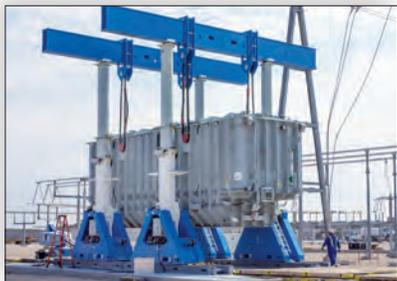
Levantamento preciso e posicionamento de cargas pesadas.
