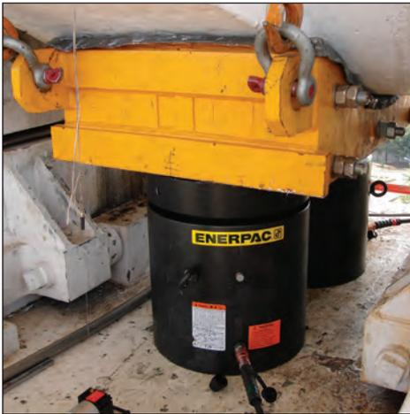
▲ Levantamento pesado e nivelamento de fundações. A porca trava oferece sustentação mecânica da carga por um longo período de tempo.
