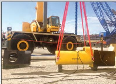
◀ Um de tres cilindros customizados SyncHoist usado para posicionar o módulo de uma usina nuclear de 1.140 tons.
