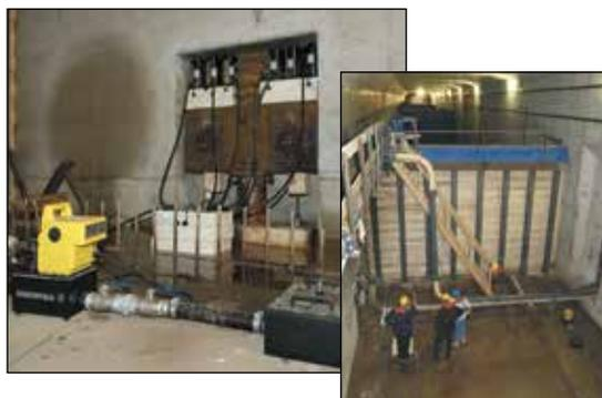
◀ Os cilindros Enerpac, leves, de alumínio RAC-506 são ideais para ambientes molhados, tais como este túnel sob o rio (Linha de Trem de Alta Velocidade na Holanda).
