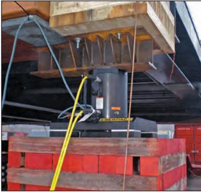
◀ Aplicação típica de levantamento por estágio usando um sistema personalizado Enerpac para levantar Akkerwinde, a ponte de madeira de 360 ton. na Holanda.
